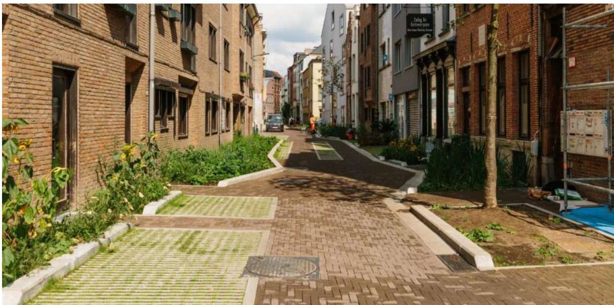
Figuur 21. Voorbeeld van de toepassing van halfverharding voor parkeervakken in de Tuinstraat (Lange Riddersstraat) in Antwerpen (Bron: Stad Antwerpen).
