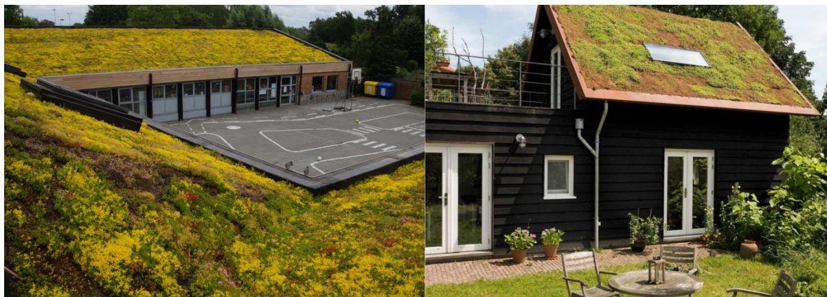
Figuur 30. Voorbeelden van een groendak. Links wordt een groendak toegepast op een groot, weinig hellend dak van de basisschool in Meerdonk Sint-Gillis-Waas. Rechts is het toegepast op het dak van een privé woning. Bron: Blauwgroen Vlaanderen.
