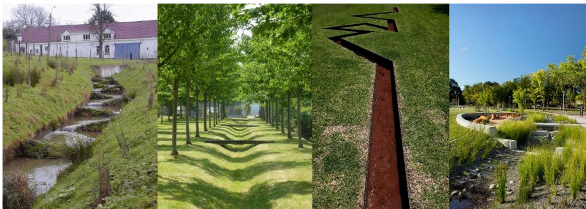
Figuur 28. Blauwgroene afvoerwegen bieden een breed spectrum aan inrichtingsmogelijkheden. Van links naar rechts: een gracht met kunstmatige meandering om te vertragen, een laanvormige infiltratiekanaal, een zeer strak
