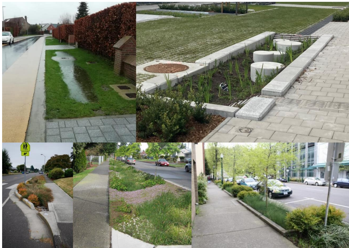
Figuur 19. Vlnr en vbno: (1) Infiltratiekom langs de straat. © Kruisem; (2) Bufferend plantvak (Aziëlaan Wilrijk, tuinstraat). © Aquafin; (4, 5 en 6) Mogelijke vertragsmaatregelen waarbij de inplanting zoveel mogelijk wordt uitgespreid en focust op water vasthouden. © Aquafin.
