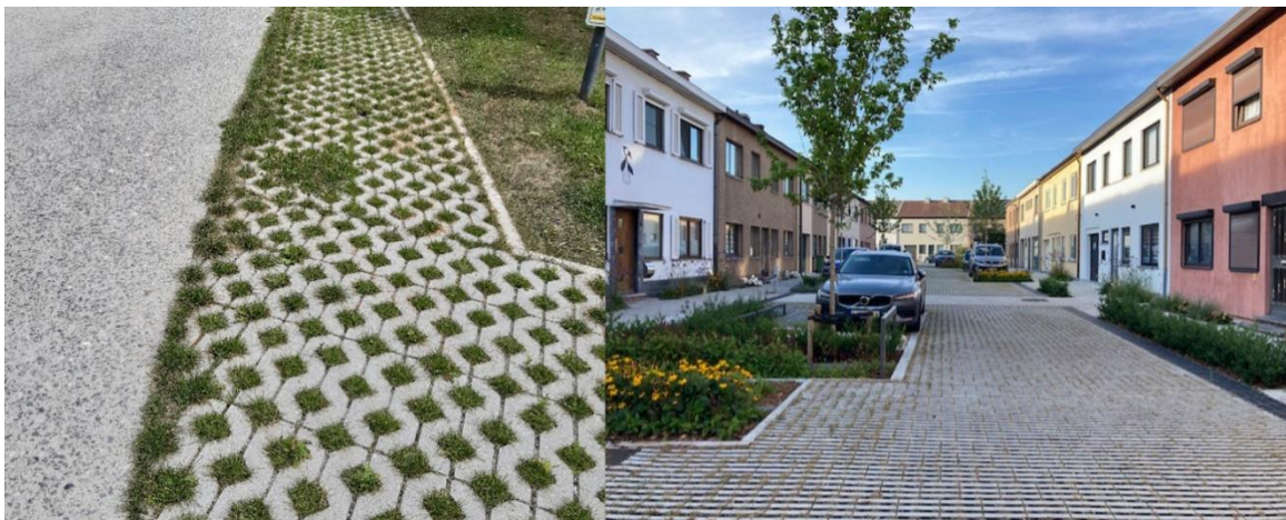
Figuur 17: Vlnr: (1) Versmald voet-fietspad met uitwijkmogelijkheid over waterdoorlatende verharding (Overijse). © Aquafin; (2) Tuinstraat met zowel rijweg als parkeervakken aangelegd in halfverharding (Aziëlaan, Wilrijk). © Aquafin.
