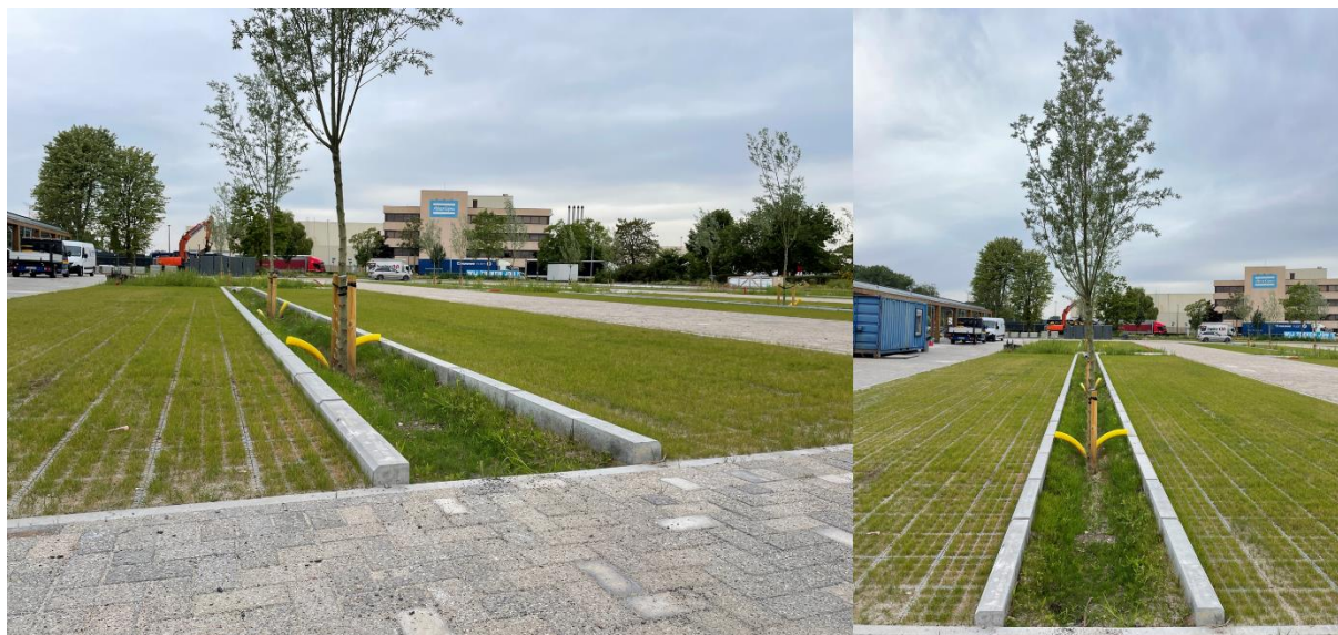
Figuur 33. Voorbeeld van personeelsparking met parkeerplekken uitgevoerd in grasdallen en met een infiltratiestrook in het midden waar al het hemelwater dat op de parking valt kan infiltreren. © Aquafin.
